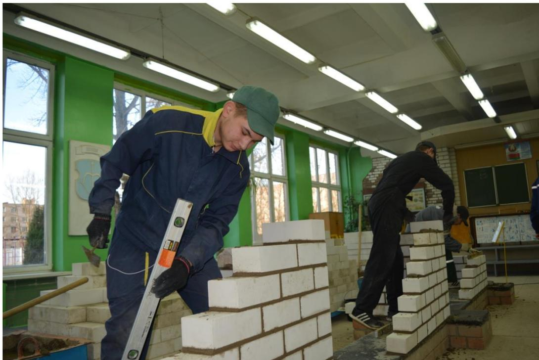
Каменщики используют ручные и механизированные орудия труда (кельму, кирку, лопату, расшивку). При кладке стен, приготовлении раствора, транспортировке материалов значителен объем ручного труда. Надо тонко чувствовать равномерность давления всей площади кирпича на растворную постель и дозировать усилия. Также для планирования и контроля всей работы в целом рабочему необходимы: пространственное воображение, техническое мышление, устойчивое внимание, наглядно-образная память.
